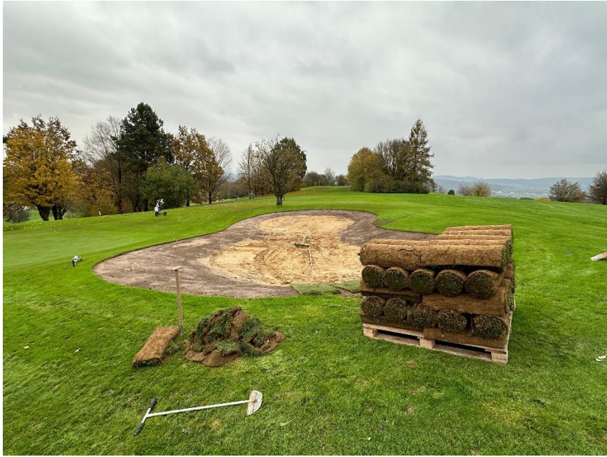
Die neuen Rasensoden werden verlegt und gewässert
